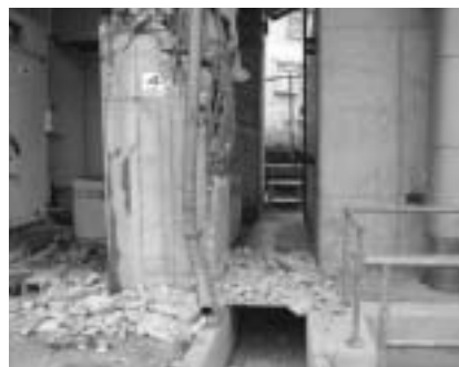
■写真—3 上越新幹線第三和南津高架橋
