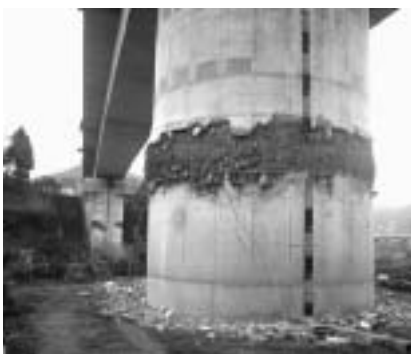
■写真—4 上越新幹線魚野川橋りょう
