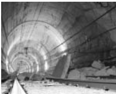
■写真—2 上越新幹線魚沼トンネル
