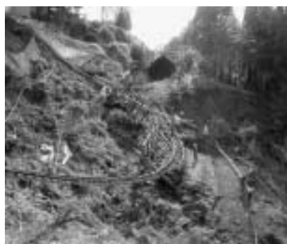
■写真—5 上越線小千谷付近
