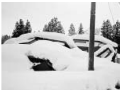
■写真―5 雪に埋もれる倒壊した家屋
