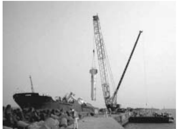
■写真—1 チルソン号撤去状況
